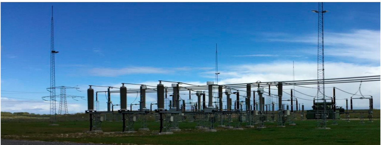
Figur 2: Eksempel på et felt (højspændingsstation Endrup)
