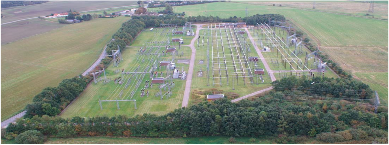
Figur 1: 400/132 kV-AIS-station Hovegård
