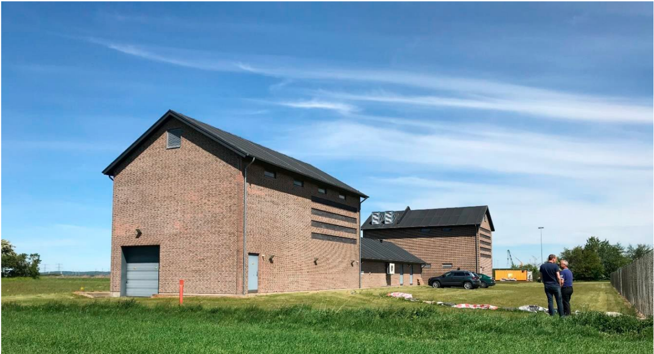
Figur 6 Eksempel på en bygning indeholdende et GIS-anlæg samt kompenseringsspole (Blåbjerg)
