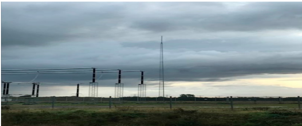
Figur 4: Eksempel på en lynfangsmast placeret for enden af en samleskinne
