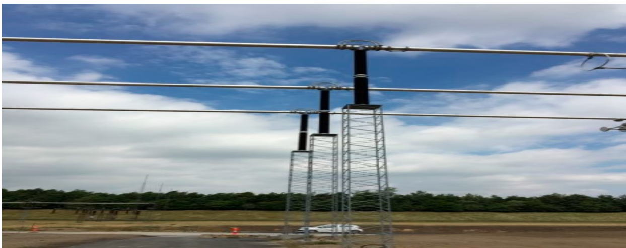
Figur 3: Eksempel på en del af en samleskinne
