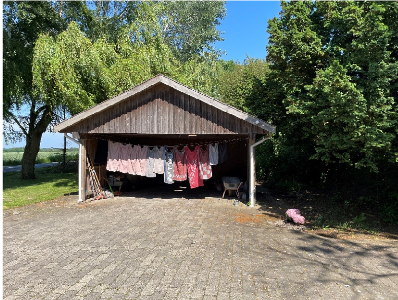
Billede 4 Carport (bygning 3)
