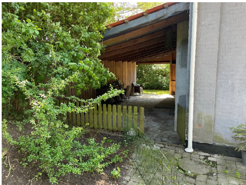
Billede 6 Overdækning (bygning A)
