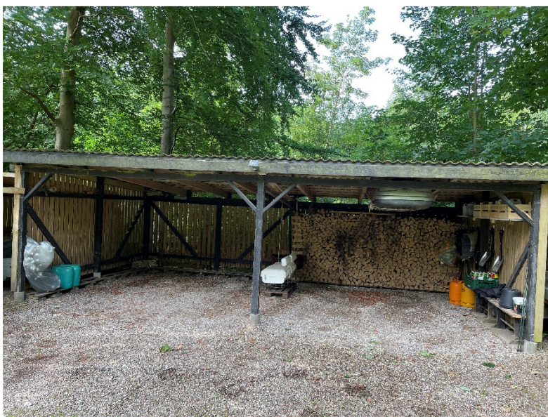
Billede 14 Carport (bygning B).
