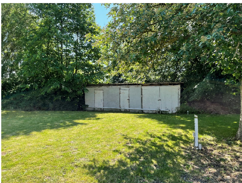
Billede 9 Udhus (bygning 2)
