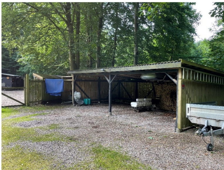
Billede 13 Carport (bygning B).
