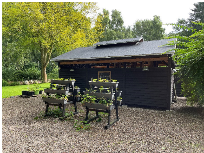
Billede 12 Overdækning/udekøkken (bygning A).
