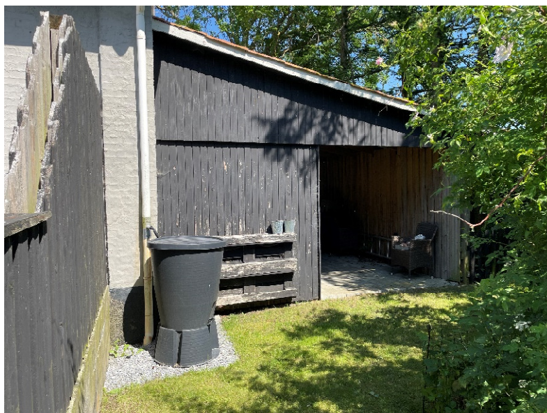
Billede 7 Overdækning (bygning A)
