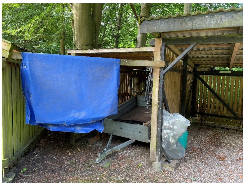
Billede 15 Carport (bygning B).
