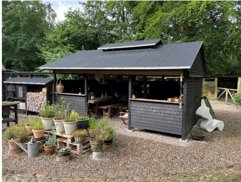
Billede 10 Overdækning/udekøkken (bygning A).
