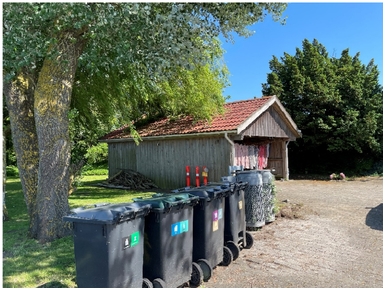
Billede 5 Carport (bygning 3)
