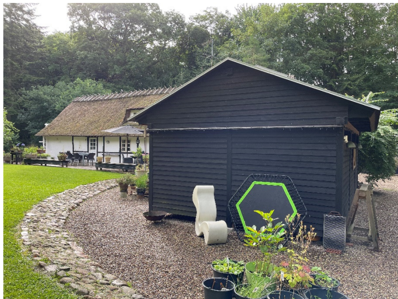
Billede 11 Overdækning/udekøkken (bygning A).
