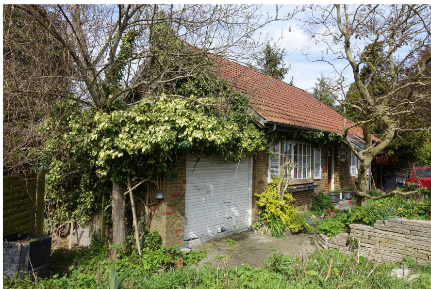
Billede 2 Garage og bolig (bygning 2 og 1).
