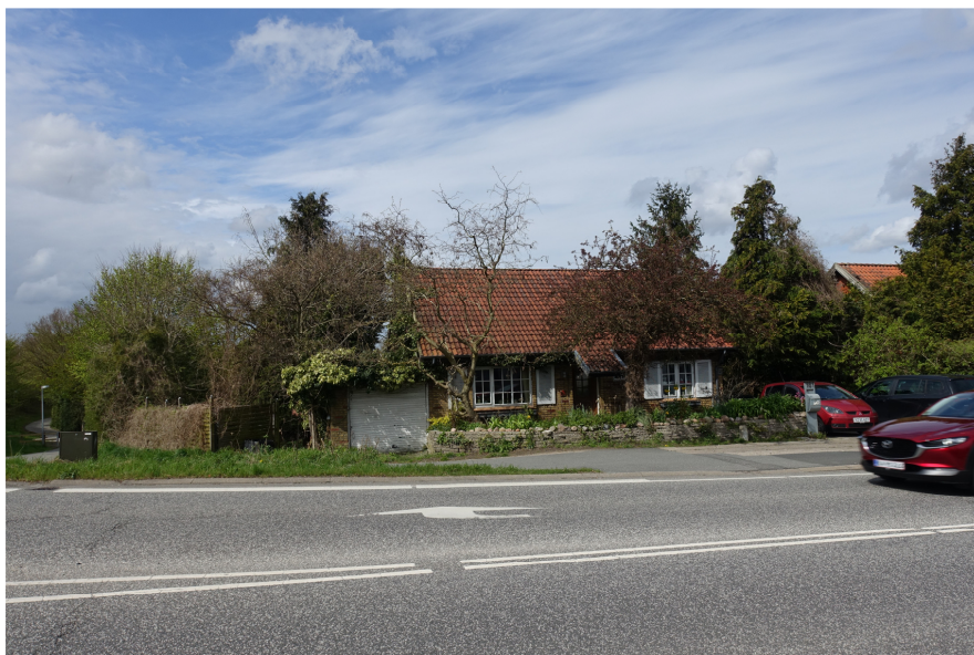
Billede 1 Garage og bolig (bygning 2 og 1).
