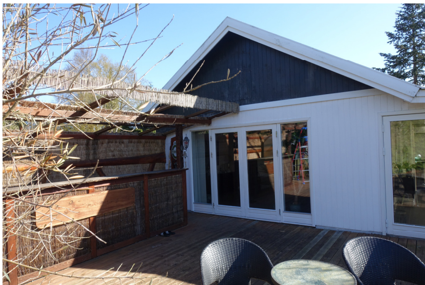
Billede 9 Delvis overdækning og sommerhus (bygning E og 1).
