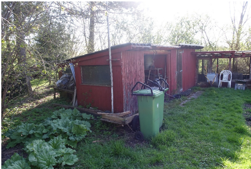
Billede 5 Udhus (bygning 5 og 4)
