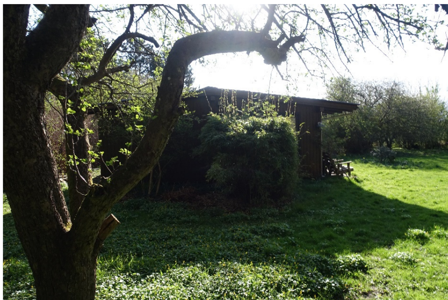
Billede 3 Sommerhus (bygning 1)
