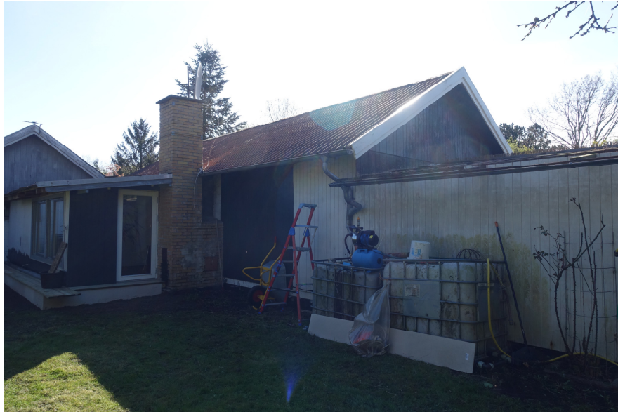
Billede 4 Anden bygning, sommerhus og delvis overdækning (bygning A, 1 og E).
