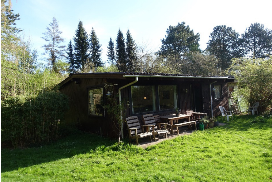
Billede 4 Sommerhus (bygning 1)
