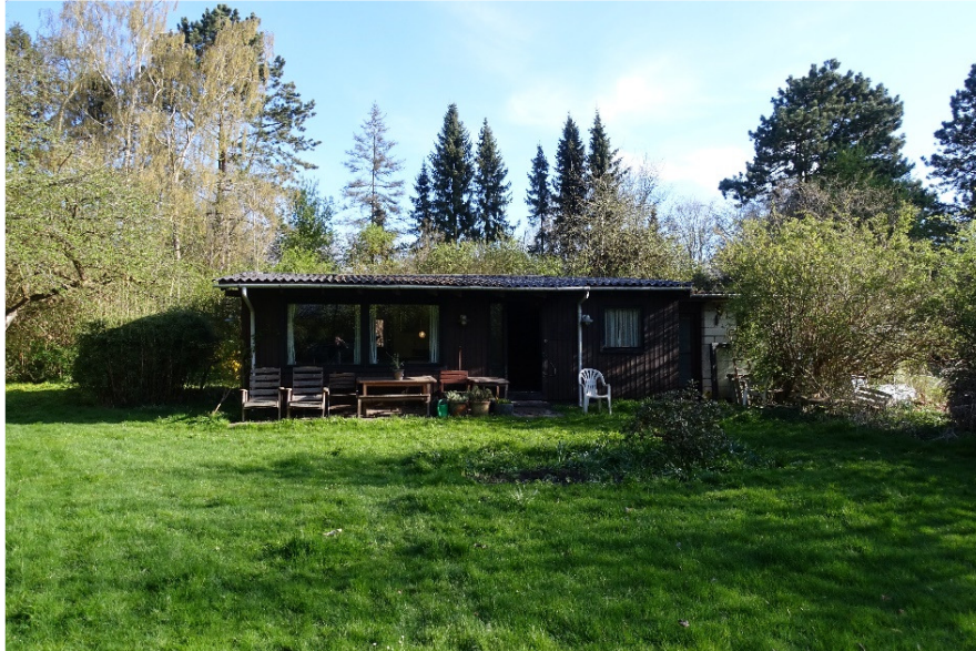
Billede 1 Sommerhus (bygning 1)
