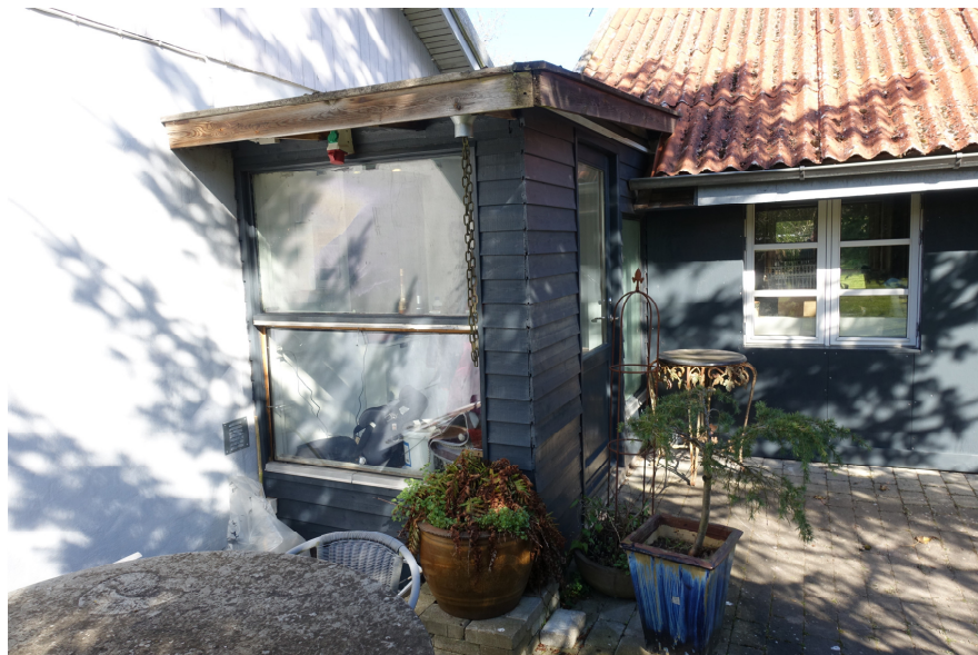
Billede 5 Anden bygning og carport (bygning B og 4).
