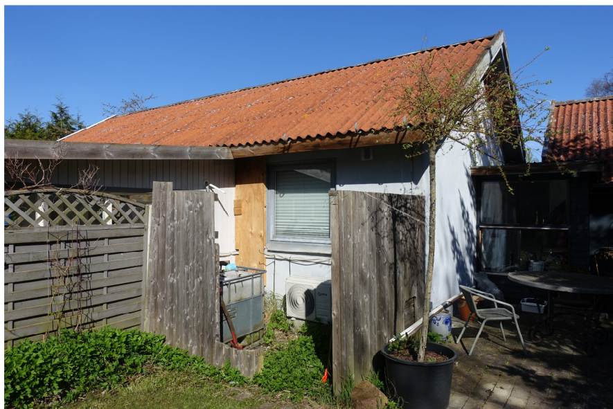
Billede 3 Sommerhus (bygning 1).
