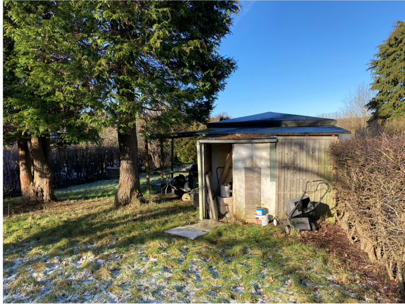
Billede 4 Udhus (bygning A).
