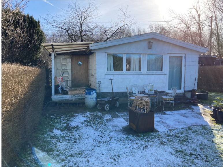
Billede 1 Beboelse og overdækket terrasse (bygning 1 og 2).
