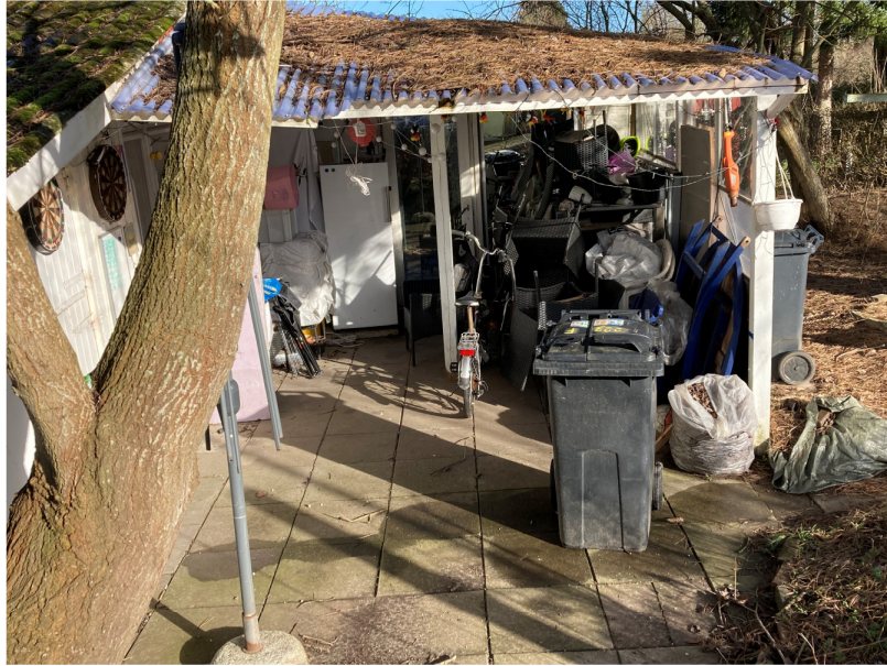
Billede 4 Overdækket terrasse (bygning 2).
