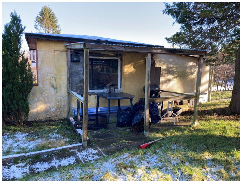
Billede 3 Beboelse og overdækket terrasse (bygning 1 og 2).
