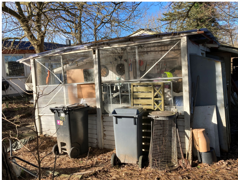
Billede 2 Overdækket terrasse (bygning 2).
