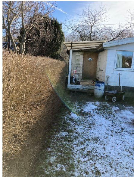
Billede 5 Overdækket terrasse og beboelse (bygning 2 og 1).
