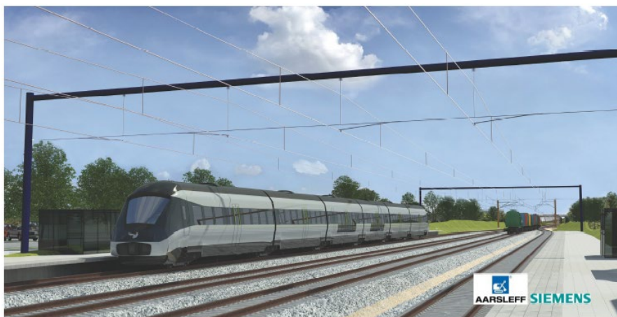
Figur 3: Visualisering af portalmaster ved dobbeltspor.
