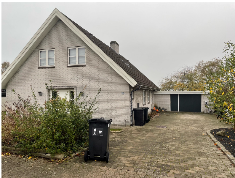
Billede 1 Bolig og garage (bygning 1 + 2)
