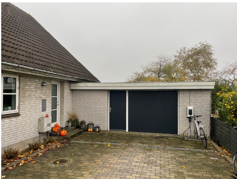
Billede 2 Bolig og garage (bygning 1 + 2)
