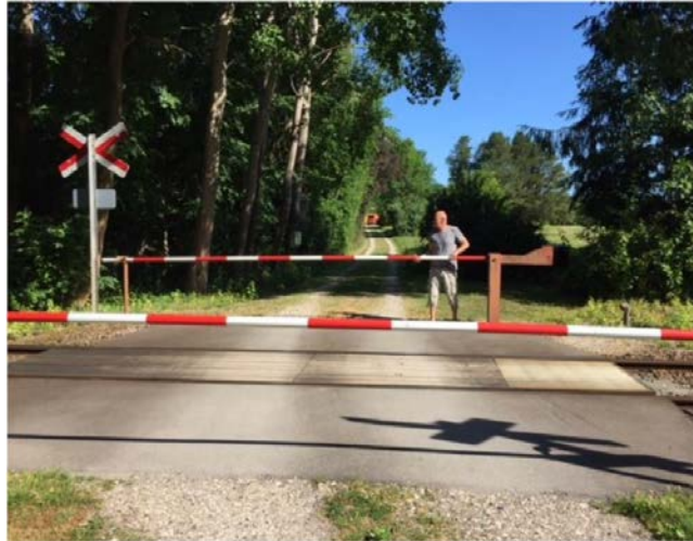
Billede 2 Overkørsel nr. 117 set fra syd mod nord
