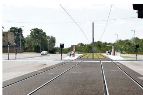
Anlæg med rilleskinnespor.
