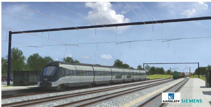
Fig. 3 Visualisering af portalmaster ved dobbeltspor
